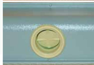
Ces dispositifs d'aération favorisent une convection naturelle de l'air, y compris à l'intérieur des banquettes (d'où la présence de passage d'air au pied des coffres).
