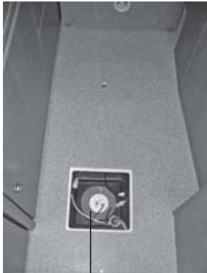
Orifice d'inspection du réservoir d'eau dans le fond du corridor
