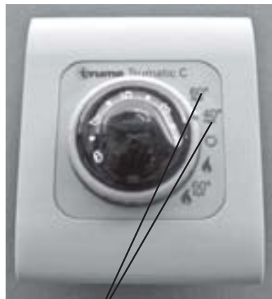
Préparation de l'eau chaude en service estival
