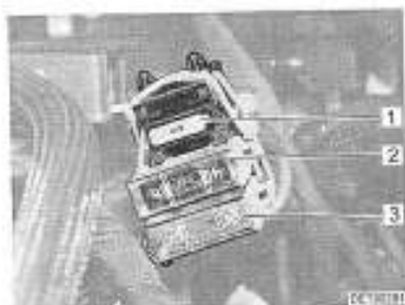
Fig. 121 Fusibles pour la batterie de démarrage (Renault)
