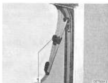
Fig. 45 Fenêtre projetante avec bras pivotants, ouverte
