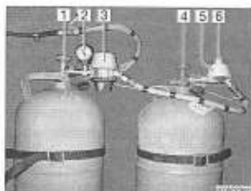
Fig. 109. Dispositif de commutation Duomatic
