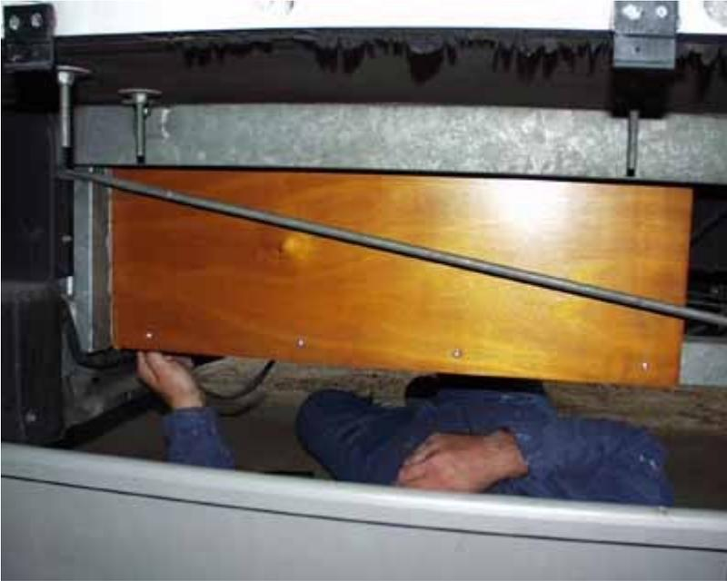
Tout est assemblé avec de la cornière galva de 30, boulonné et collé au silicone.
