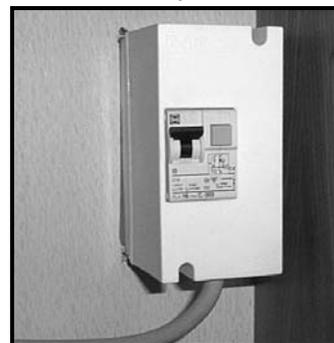
Interrupteur général disjoncteur: Interrupteur 230V. Situé au niveau de la prise 230V à l'intérieur du véhicule.
