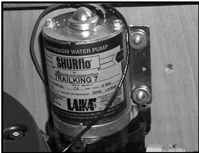
La pompe aspire l'eau du réservoir sélectionné (intérieur ou extérieur). L'eau passe au travers d'un filtre situé directement à l'entrée de la pompe et est donc propulsée dans l'installation, par les tuyaux en polybutylène hors-gel pour ensuite rejoindre les divers éléments. La pompe est pourvue de clapets et entre en fonctionnement chaque fois qu'on ouvre un robinet. Pour de plus amples informations concernant la pompe, consulter le manuel du constructeur.
