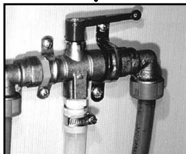
Déviateur réservoir standard/supplémentaire (en option), généralement installé à proximité de la pompe.
